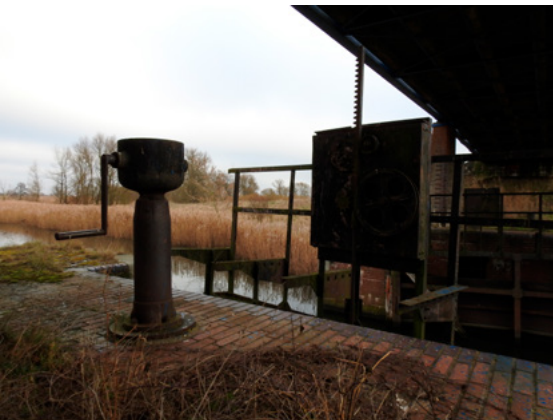
Zabytkowa Śluza Berlińska na Odrze Zachodniej z częścią systemu do ręcznego sterowania, fot. Łukasz Ławicki
